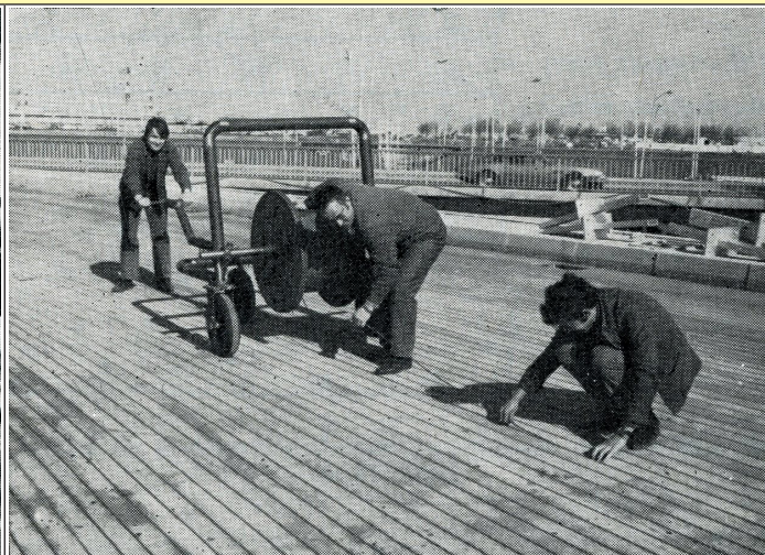
1968 Pose de la nappe chauffante sur une rampe d'accès à une plateforme de stationnement des autobus, aéroport d'Orly près de Paris (Chauffage électrique des chaussées, par Robert Félix, 1971, Musée Ultimheat* )
